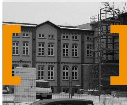
[Sanierung der Fabrikgebäude in der Viktoriastraße, Velten]
